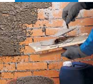
Cementový podhoz s přísadou Planicrete
