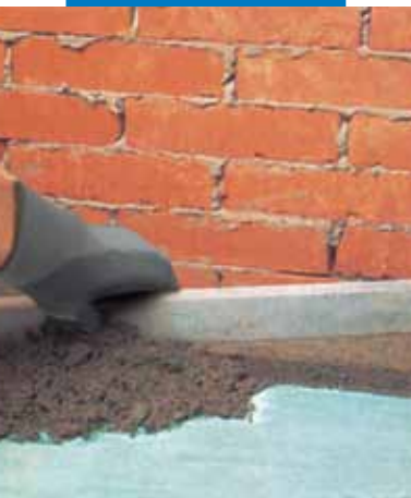
Provádění kotveného betonového potěru s přísadou Planicrete
