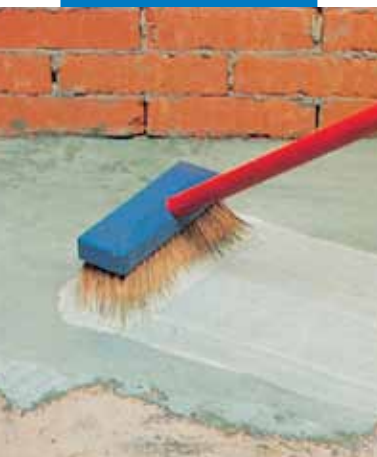
Nanesení cementového kotevního můstku s přísadou Planicrete
