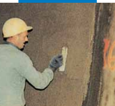
Cementová omítka s přísadou Planicrete, Dálniční tunel Ville Marie Montreal - Kanada
