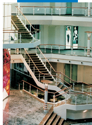
Ukázka lepení keramiky nebo mramoru na kovovou konstrukci (schodiště)
