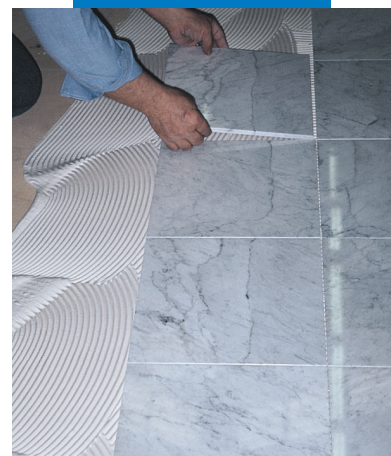
Lepení mramoru Carrara bílým Keralasticem na podklad ze dřeva
