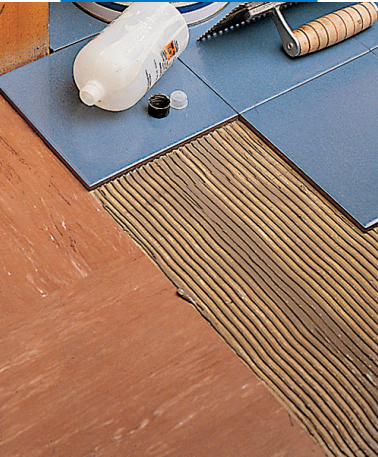
Lepení keramické dlažby na staré PVC
