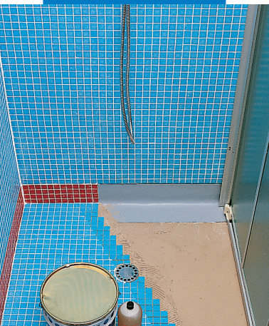
Hydroizolace a lepení v prefabrikovaném sprchovacím koutu
