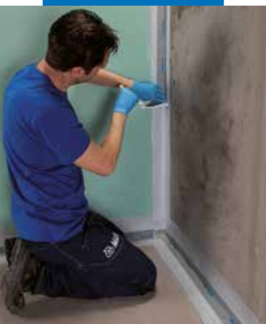
Instalace pásu Mapeband PE 120 lepeného výrobkem Mapegum WPS
