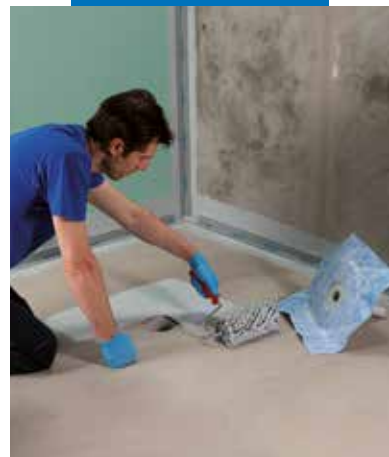
Instalace tvarovky Drain Vertical s použitím Mapegum WPS
