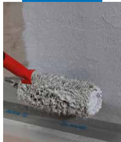
Nanášení hydroizolační stěrky Mapegum WPS válečkem
