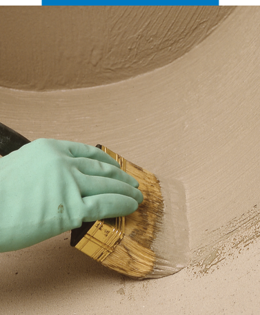
Provádění hydroizolace štětcem
