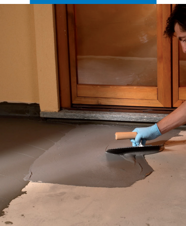
Provádění hydroizolace terasy hladítkem
