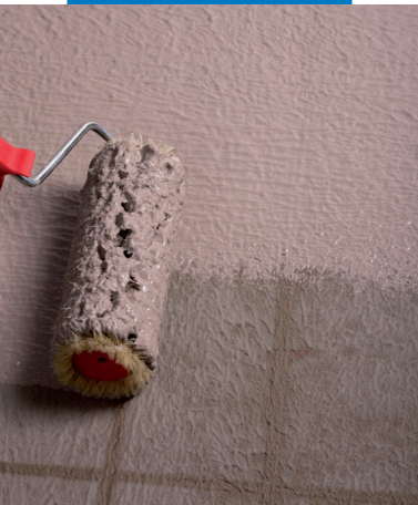
Provádění hydroizolace terasy válečkem
