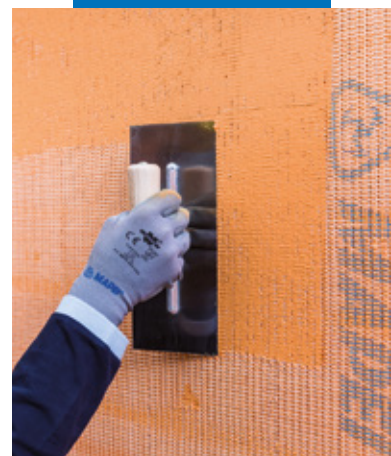
Vkládání síťoviny Mapetherm Net do čerstvé vrstvy stěrky Mapetherm Flex RP
