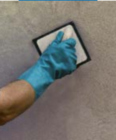
Konečná úprava povrchu PoroMapu Finitura houbovým hladítkem
