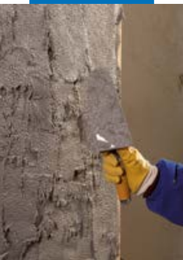
Aplikace malty PoroMap Intonaco zednickou lžící
