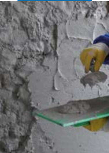
Aplikace malty PoroMap Intonaco zednickou lžící
