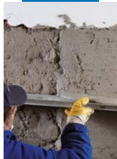
Stahování malty PoroMap Intonaco stahovací latí
