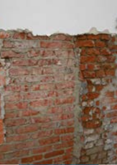
Zdivo po odstranění omítky
