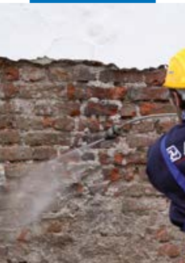
Oplach zdiva tlakovou vodou
