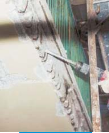
1. Rekonstrukce přední strany betonového plátu na balkoně, příprava podkladu
