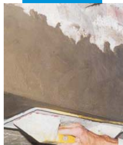
5. Lokální oprava betonového trámu
