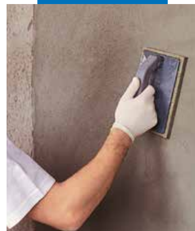
Konečná úprava povrchu Planitop 540 houbovým hladítkem
