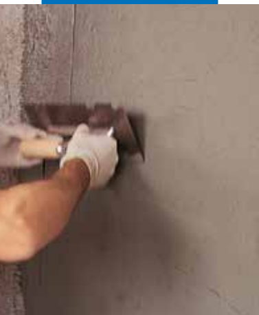
Aplikace malty Planitop 540 ocelovým hladítkem
