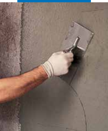
Vyhlazení povrchu Planitop 540 ocelovým hladítkem
