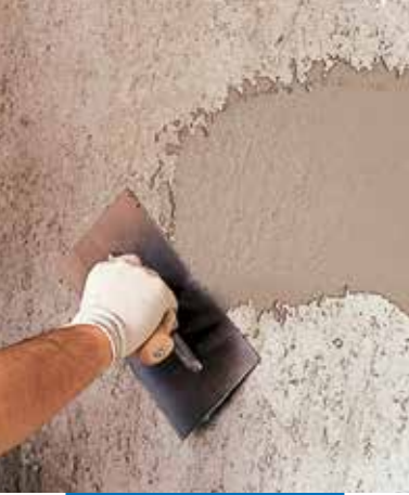
Aplikace malty Planitop 540 ocelovým hladítkem
