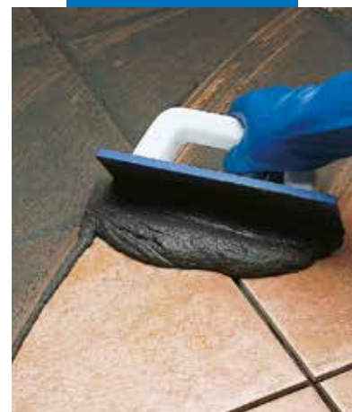
Spárování obkladů pryžovým hladítkem
