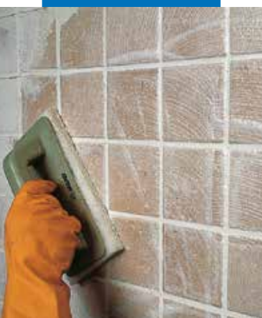
Konečná úprava jedenkrát pálených obkladů houbou Scotch-Brite®
