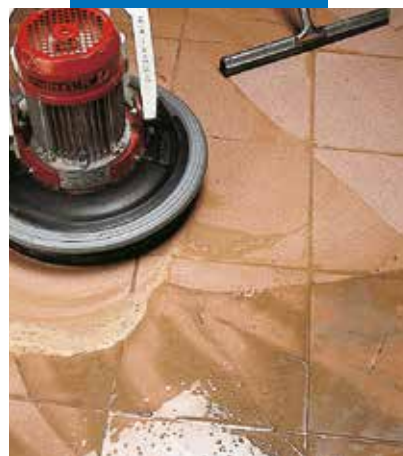
Konečná úprava dlažby gres elektrickým spárovacím a čistícím strojem a stěrkou
