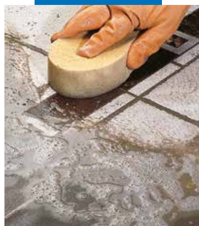
Dočištění keramické dlažby s vloženými dřevěnými prvky houbou
