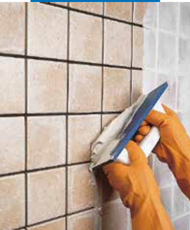
Spárování jedenkrát pálených obkladů gumovou stěrkou
