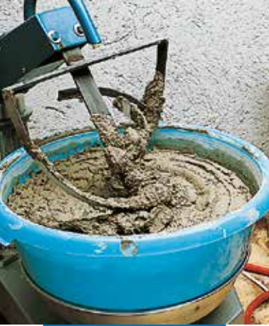
Příprava v malé míchačce na maltu
