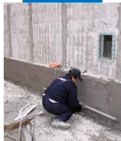
Stahování omítky latí
