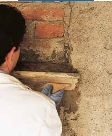
Oprava starého cihelného zdiva
