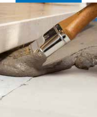
Aplikace Mapebandu SA ve špatně dostupných prostech, jako je např. pod dveřním prahem
