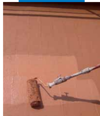
Aplikace Aquaflexu Roof válečkem s dlouhým vlasem
