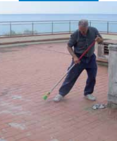
Čištění podkladu před aplikací Aquaflexu Roof
