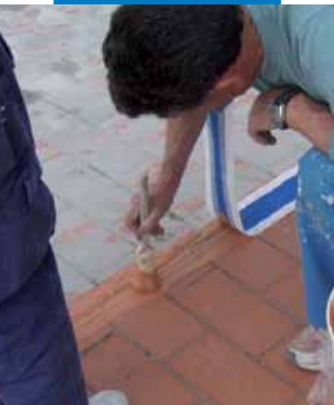
Těsnění dilatačních spár s použitím Mapebandu lepeného Aquaflexem Roof
