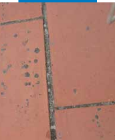
Stará dlažba typu cotto, která vyžaduje úpravu před aplikací Aquaflexu Roof
