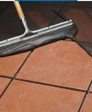
Spárování dlažby z terakoty gumovým hladítkem
