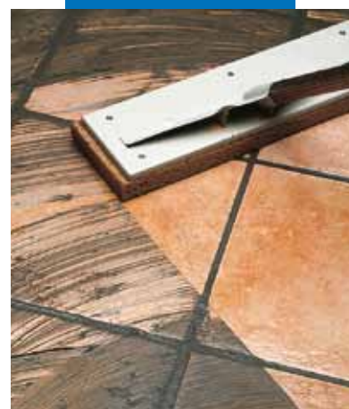
Čištění jedenkrát pálené dlažby houbovým hladítkem
