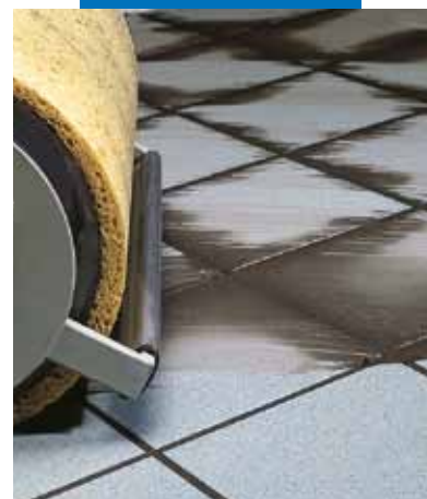
Strojní dokončování povrchu dlažby
