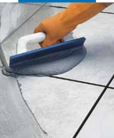
Spárování keramické dlažby gumovou stěrkou
