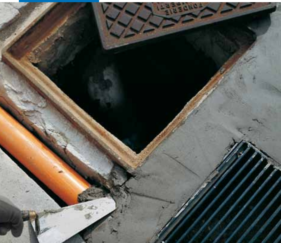
Instalace potrubí a kanalizačního poklopu pomocí Lampocemu
