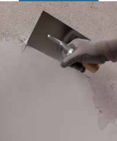
Aplikace první vrstvy Mape-Antique FC Ultrafine
