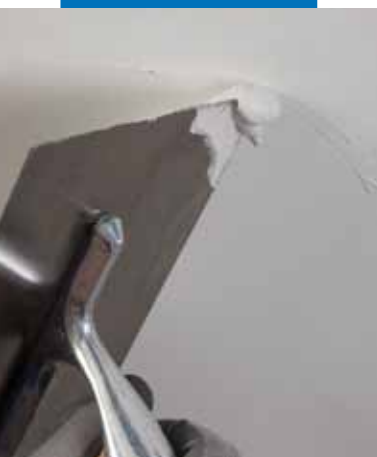
Vyhlazování výrobku ocelovým hladítkem
