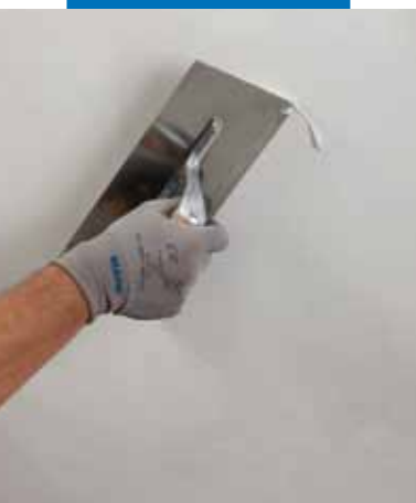
Způsob nanášení Mape-Antique FC Ultrafine
