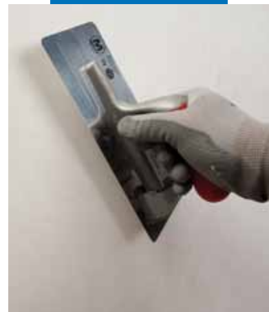
Aplikace druhé vrstvy Mape-Antique FC Ultrafine
