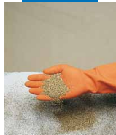
Zásyp čerstvého Mapecoat I 24 suchým pískem
