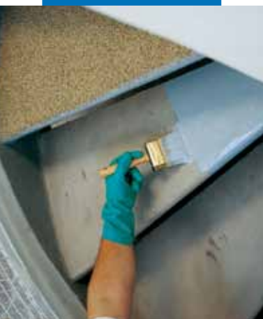
Aplikace Mapecoatu I 24 na beton
