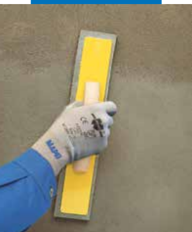
Vyhlazování houbovým hladítkem
