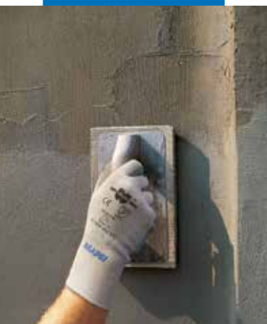
Vyhlazování houbovým hladítkem
