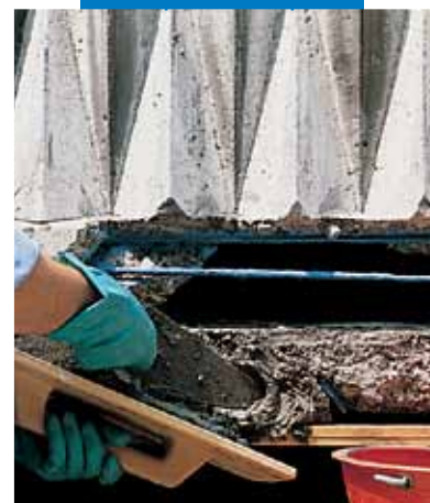
Oprava balkonu Mapegroutem T40
