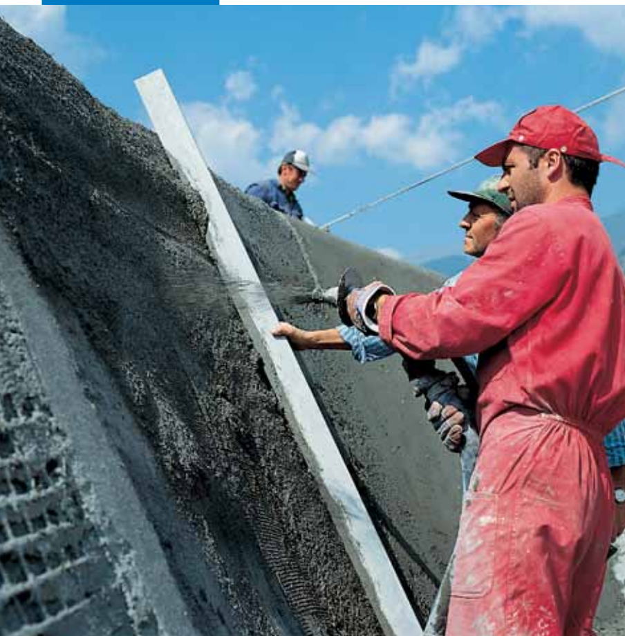
Aplikace Mapegroutu T40 strojní omítačkou
