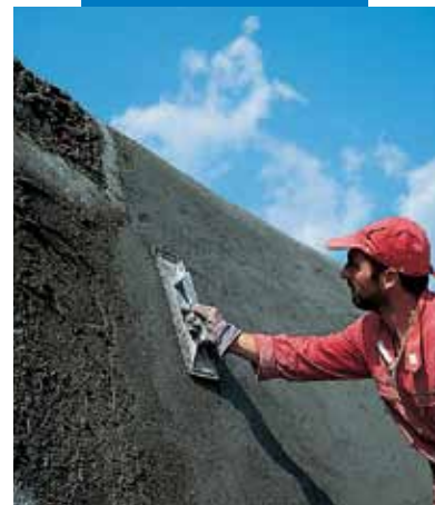
Konečná úprava Mapegroutu T40 hladítkem
