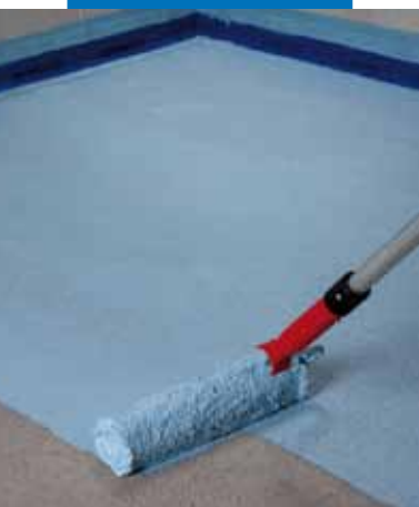
Nanášení první vrstvy Mapelasticu AquaDefense na potěr válečkem
