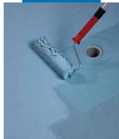
Nanášení druhé vrstvy Mapelasticu AquaDefense válečkem
