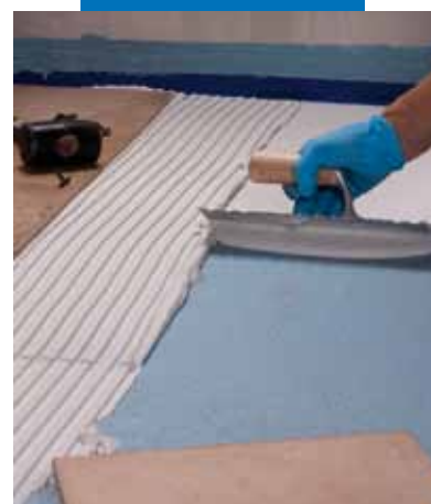
Lepení dlažby na Mapelastic AquaDefense
