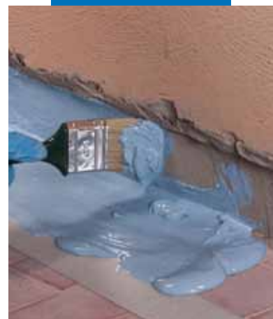
Nanášení Mapelasticu AquaDefense před instalaci Mapebandu ve styku stěna-podlaha
