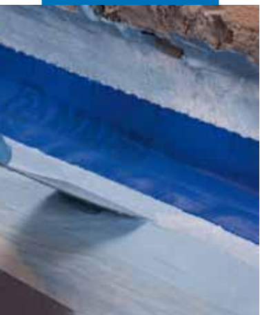
Instalace pásu Mapeband ve styku stěna-podlaha do stěrky Mapelastic AquaDefense
