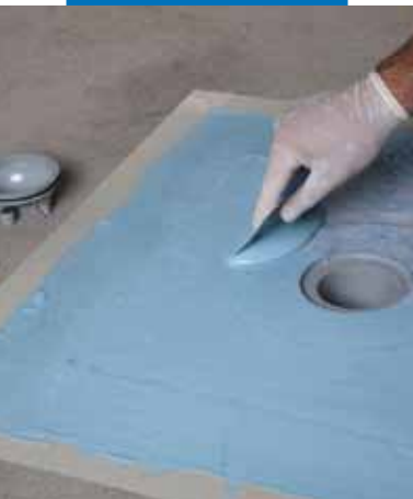
Vložení tkaniny odvodňovací vpusti Drain Vertical do Mapelasticu AquaDefense
