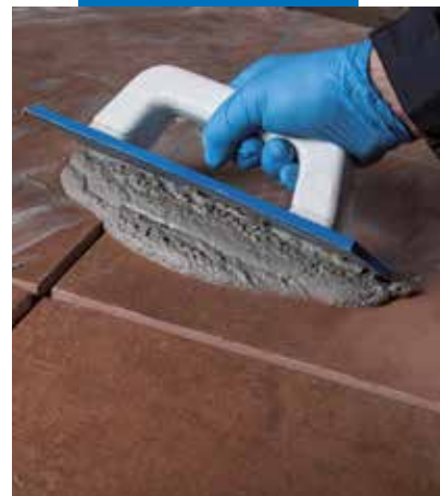
Výplň spár v dlažbě Ultracolem Plus
