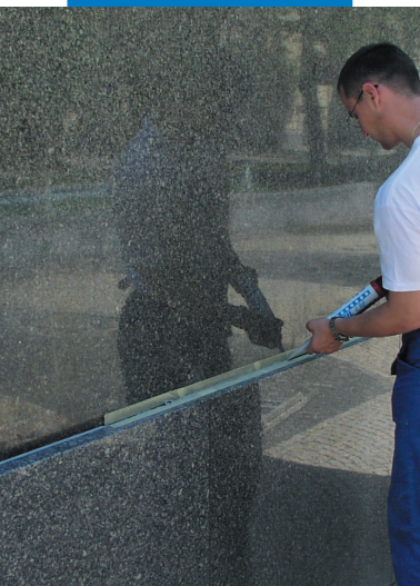
Těsnění spáry na fasádě s použitím Mapesilu LM
