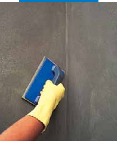
Konečná úprava houbovým hladítkem
