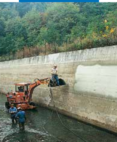
Nanášení Planisealu 88 nástřikem v přírodním kanálu hydroelektrárny
