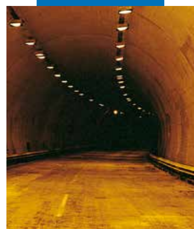
Nanášení bílého Planisealu 88 nástřikem v dálničním tunelu
