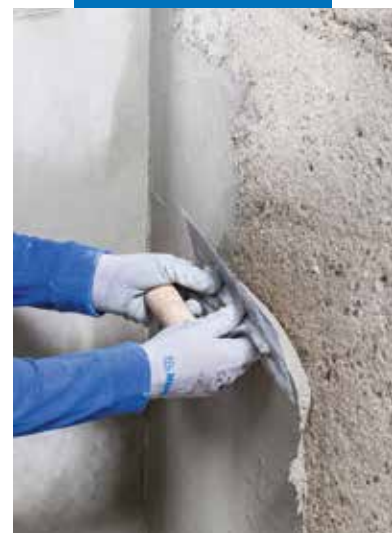
Aplikace Planitopu Rasa & Ripara R4 hladítkem
