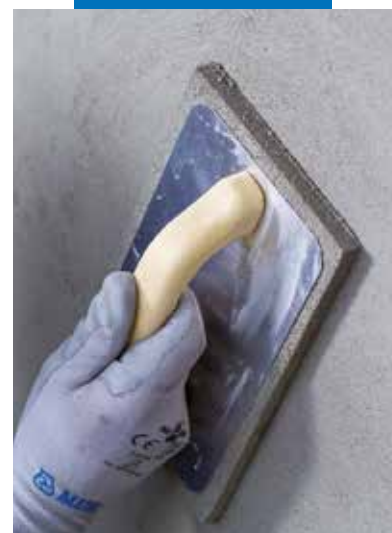
Vyhlazení povrchu Planitopu Rasa & Ripara R4 houbovým hladítkem
