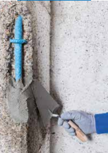
Aplikace Planitopu Rasa & Ripara R4 zednickou lžící
